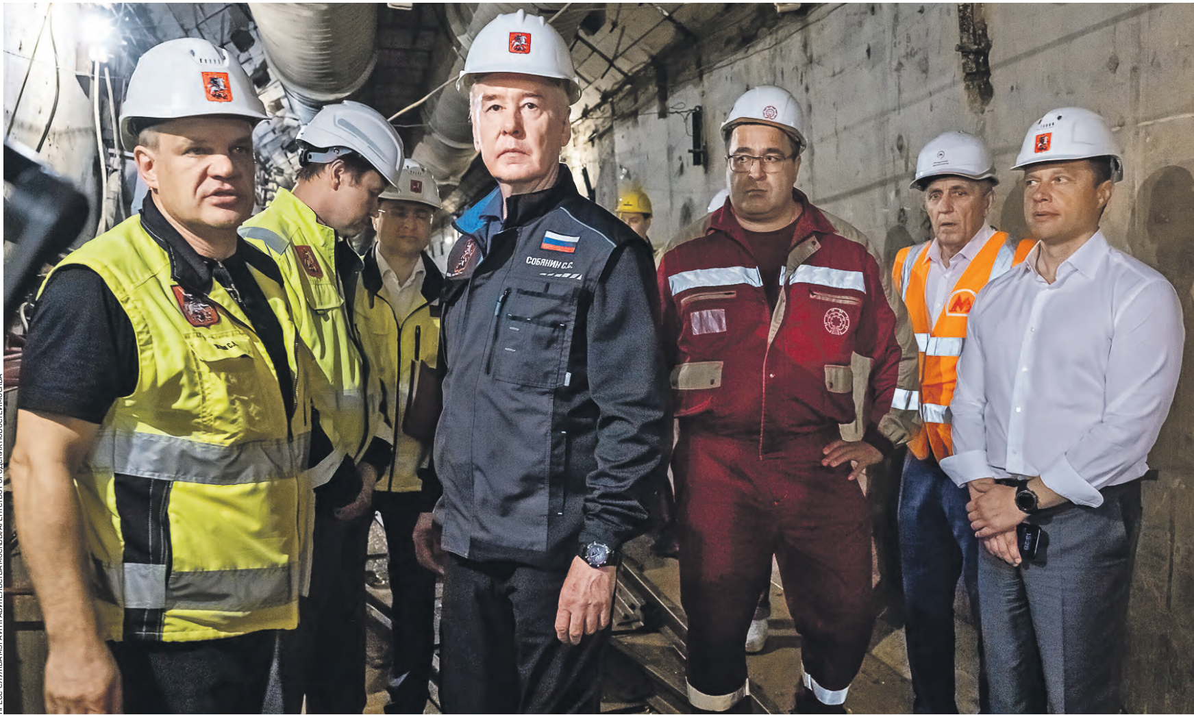
15 июля, Мэр Москвы Сергей Собянин (в центре) и первый заместитель генерального директора компании-подрядчика Сергей Жуков (слева) осмотрели ход работ на строительной площадке станции «Достоевская» Кольцевой линии метро. Она в настоящее время готова на треть
