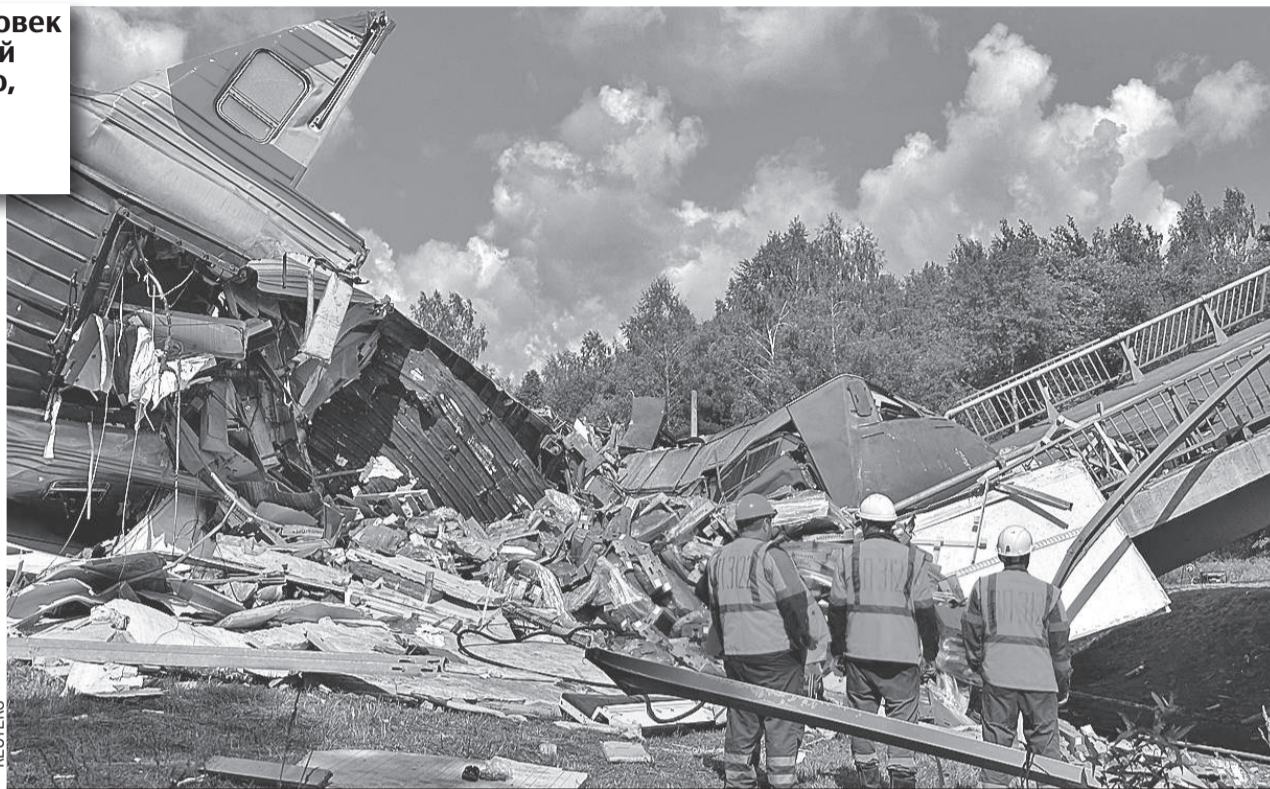
Конструкции моста обвалились прямо перед локомотивом. На то, чтобы разобрать завалы и восстановить движение, понадобилось больше суток.
